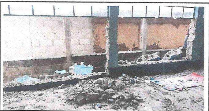
Foto 5: Derribamiento de paredes para reforzar paredes en aulas.
